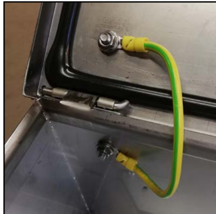
7. Detalj av jordning och packning
